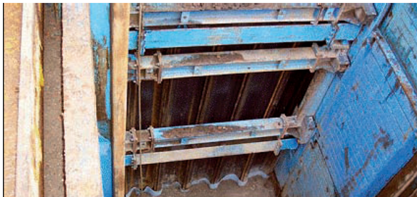
Figura 30 - Blindaggio di testata tramite palancole
