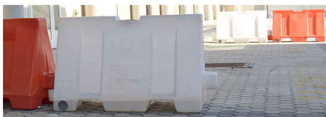
Esempio di recinzione temporanea per delimitare il cantiere in caso di circolazione a senso unico alternato
