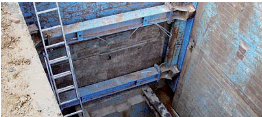
Figura 23 - Blindaggio di testata ad una rotaia (foto)
