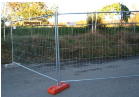
Esempio di recinzione metallica per delimitare il cantiere a fine giornata
