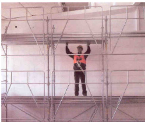
montaggio e smontaggio dal basso degli intavolati delle stilata
