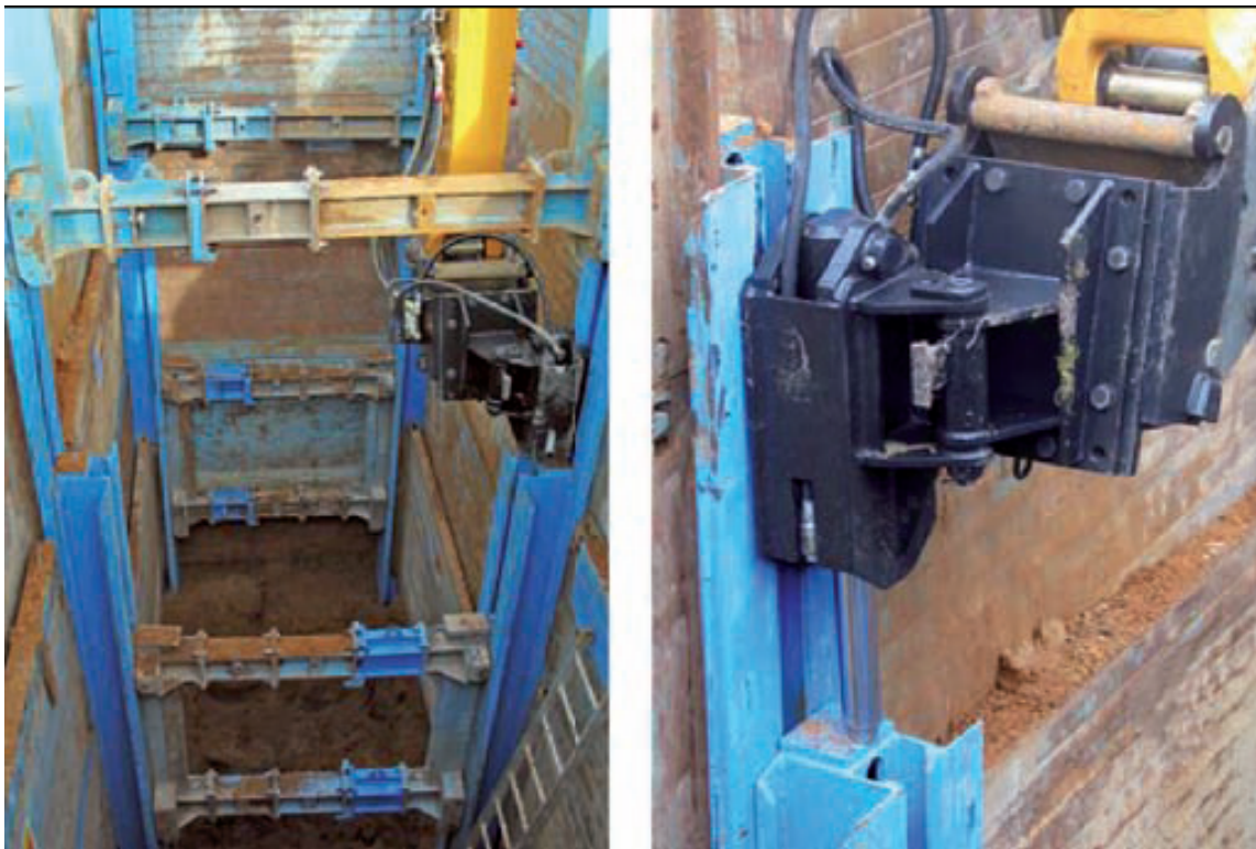
Figura 21 - Blindaggio con accoppiamento di due unità di blindaggio per grosse profondità (foto)
