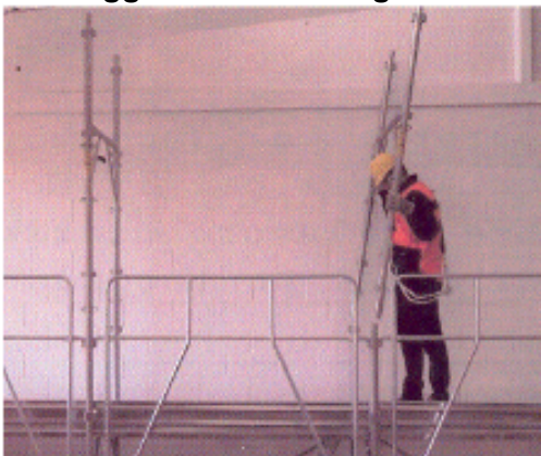
Montaggio e smontaggio dal piano inferiore dei correnti e dei parapetti
