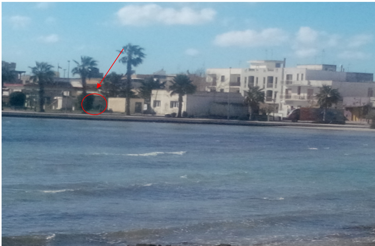
Fig. 5.1 : Vista dal punto bersaglio (Villa Menelao) verso l'impianto di depurazione
