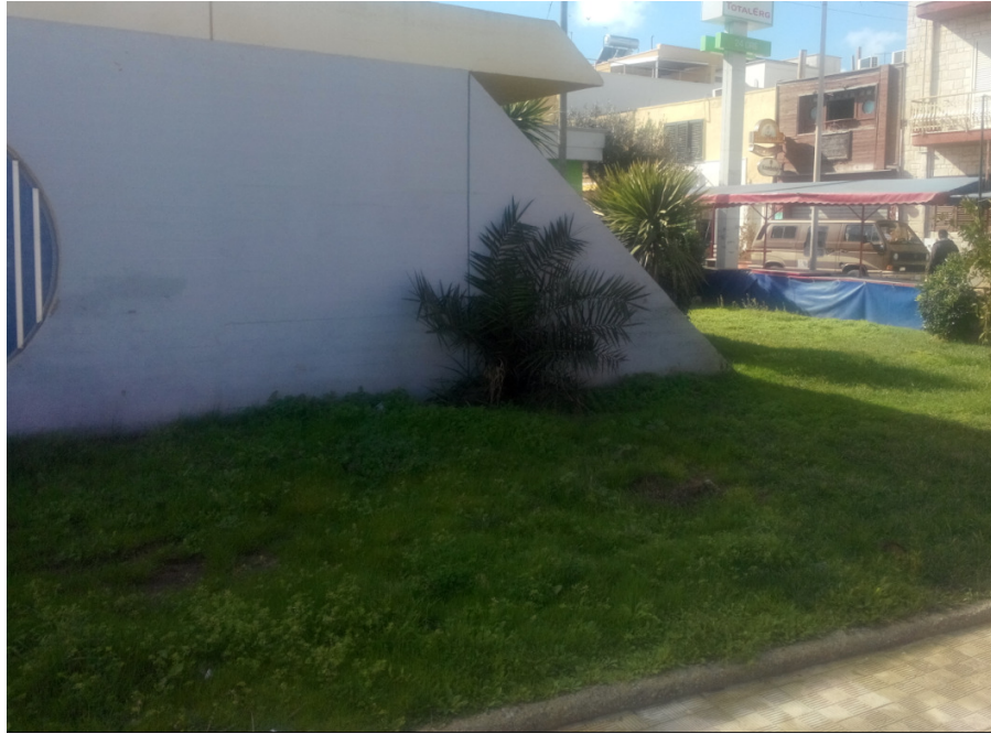
Area ubicazione impianto di sollevamento fognario stato dei luoghi
