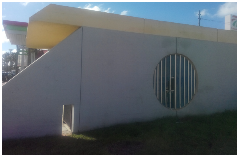
Area ubicazione impianto di sollevamento fognario stato dei luoghi
