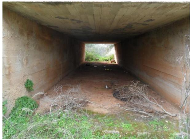
Le modalità di realizzazione dell'attraversamento saranno le stesse previste nel progetto definitivo. L'attraversamento avrà una lunghezza totale pari a 37,50 m e sarà realizzato come segue ( cfr. Allegato **CP 5-Attraversamento Canale Asso**):
