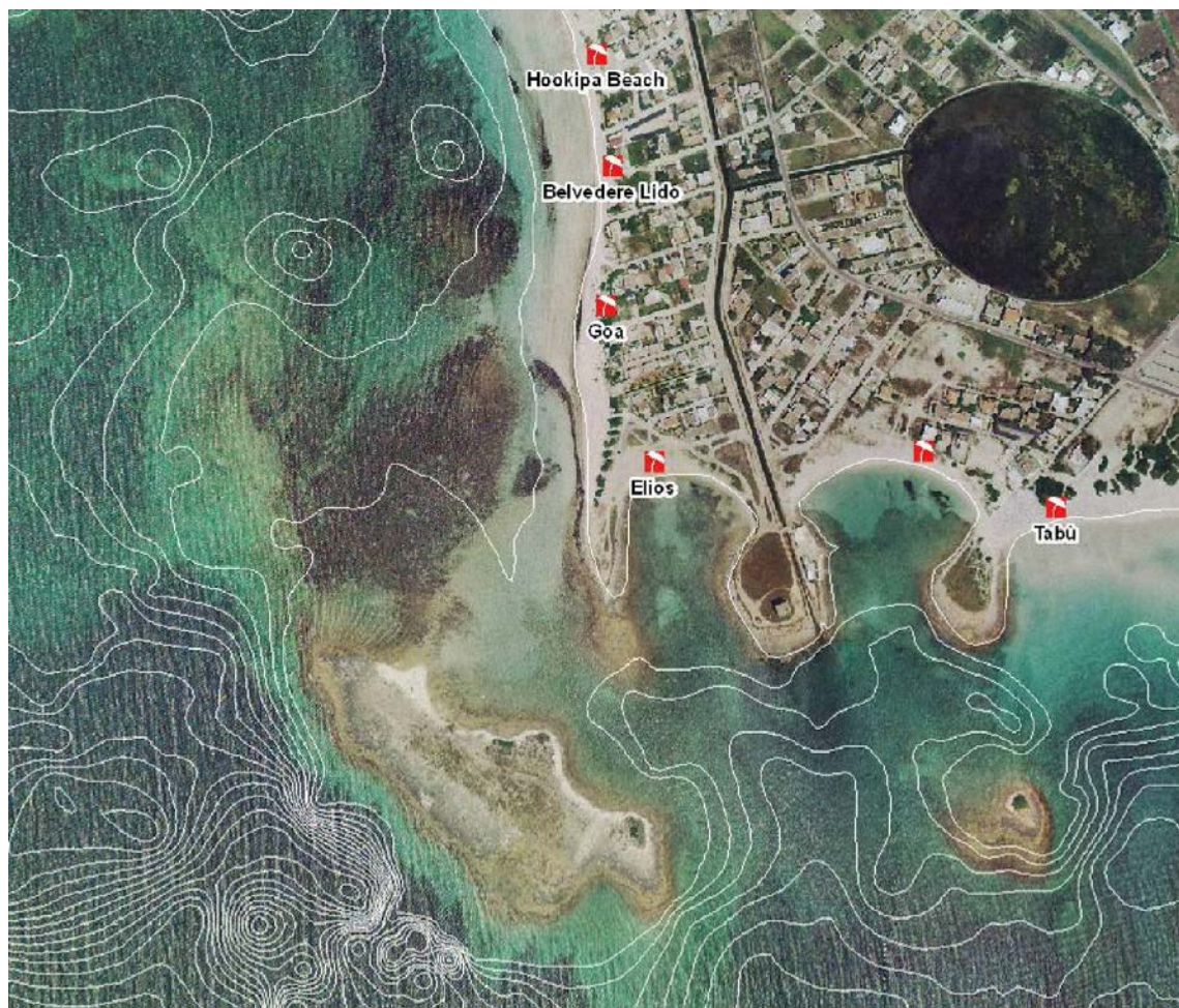
Figura 7.8.6.4 –Ortofoto del 2005: batimetria e moto ondoso proveniente dal III quadrante.
